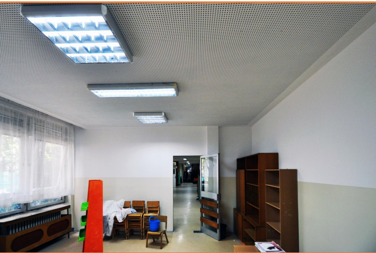
Dečiji vrtić Finalni izgled nakon ugradnje Cleaneo plafona
