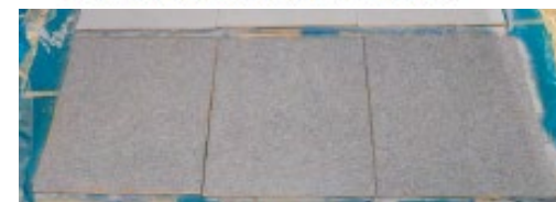
Slika 4b: Nanošenje boje putem kompresora
