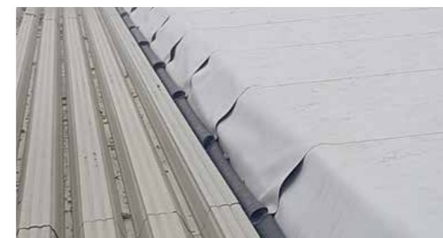
Izvedba in zaščita izolacije, t. i. dnevni zaključki
