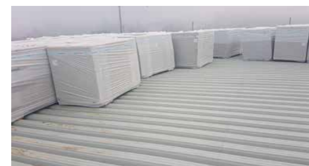
Palete strešnih plošč kamene volne na strehi
