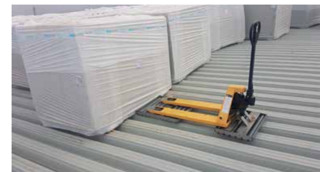
Transportni voziček za palete po strehi
