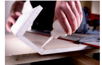
Knauf Diamant SX falten und kleben (Foto: © Mafell AG)
