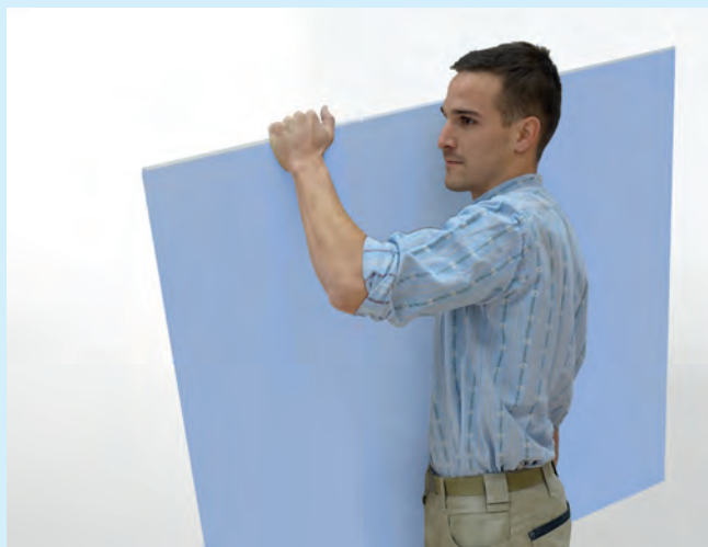
Einzelplatten werden hochkant getragen.
