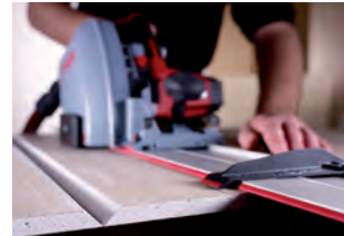
Knauf Diamant SX fräsen (Foto: © Mafell AG)
