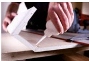
Pliage et collage de Knauf Diamant SX (photo : © Mafell AG)
