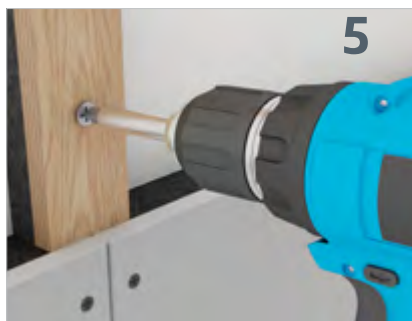
Stolperne placeres med en indbyrdes afstand på 550 mm og fastgøres med skruer pr. 600 mm lodret. Elementet fastgøres med skruer RA 25 med en afstand på 200 mm.
