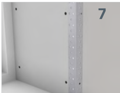
Udadgående hjørner kan forsynes med en hjørnebeskytter fx Knauf Wet-Stick for at give styrke og lette spartelarbejdet.
