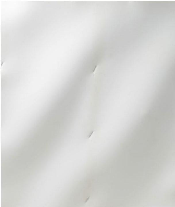
Illustration 53 : Voilement par cisaillement de la plaque de plâtre
